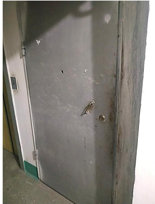
Фото № 2. Вид входной двери, расположенного по адресу: ***
