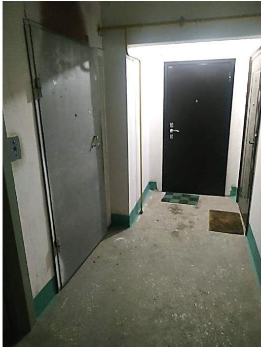
Фото № 1. Общий вид подъезда, расположенного по адресу: ***
